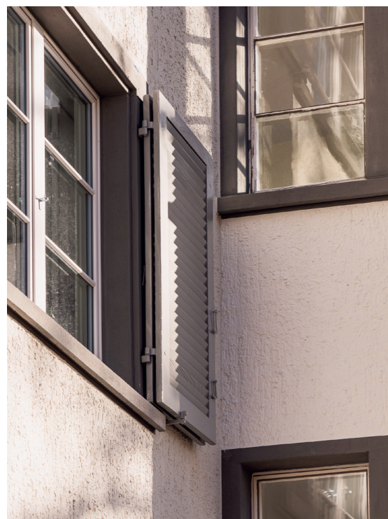
Die Rekonstruktion des 90-jährigen Verputzes war eine Herausforderung.
